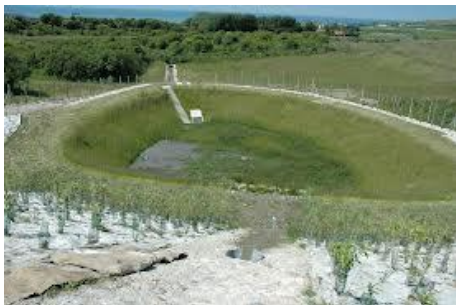
Bassin de rétention
